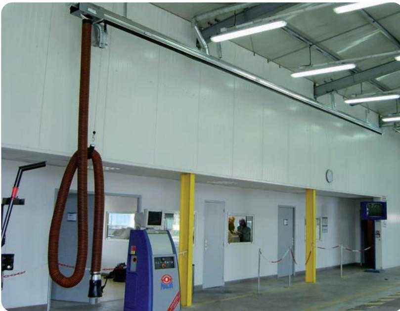
**Rail d'extraction pour contrôle technique.**
