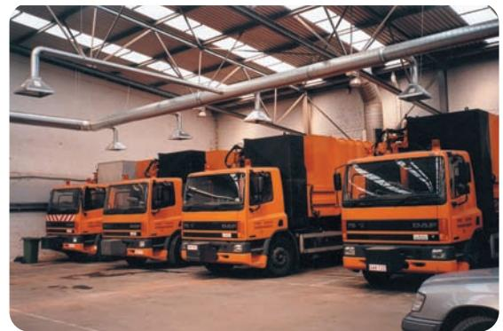
Ventilation haute pour véhicules de ramassage d'ordures /
